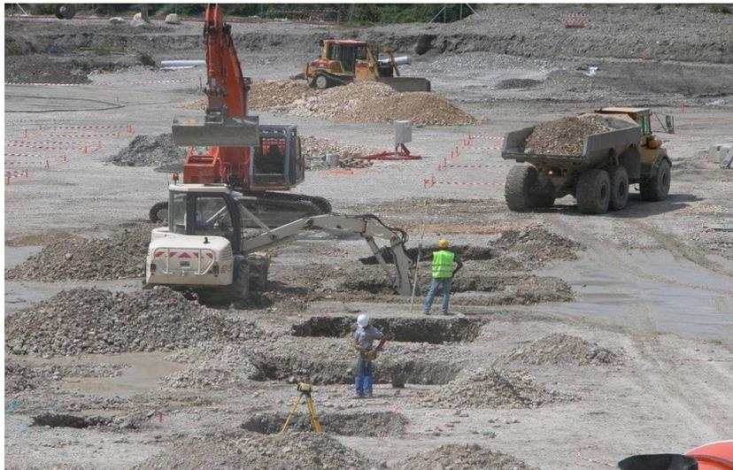
**Fig. 4.1** — Amélioration d'un terrain par induction hydraulique (Substitution du sol par du gravier dans un chantier à Saint Martin d'Hères en 2006, France).
