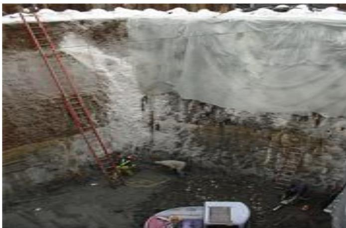
**Fig. 4.2** — Stabilisation provisoire des parois d'un fond par la technique de congélation.
